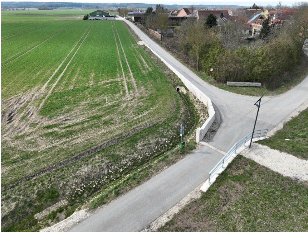
Abbildung 2: Drohnenaufnahme Hochwasserschutzmauer und mobiles Element (Quelle: WWA Ansbach)
