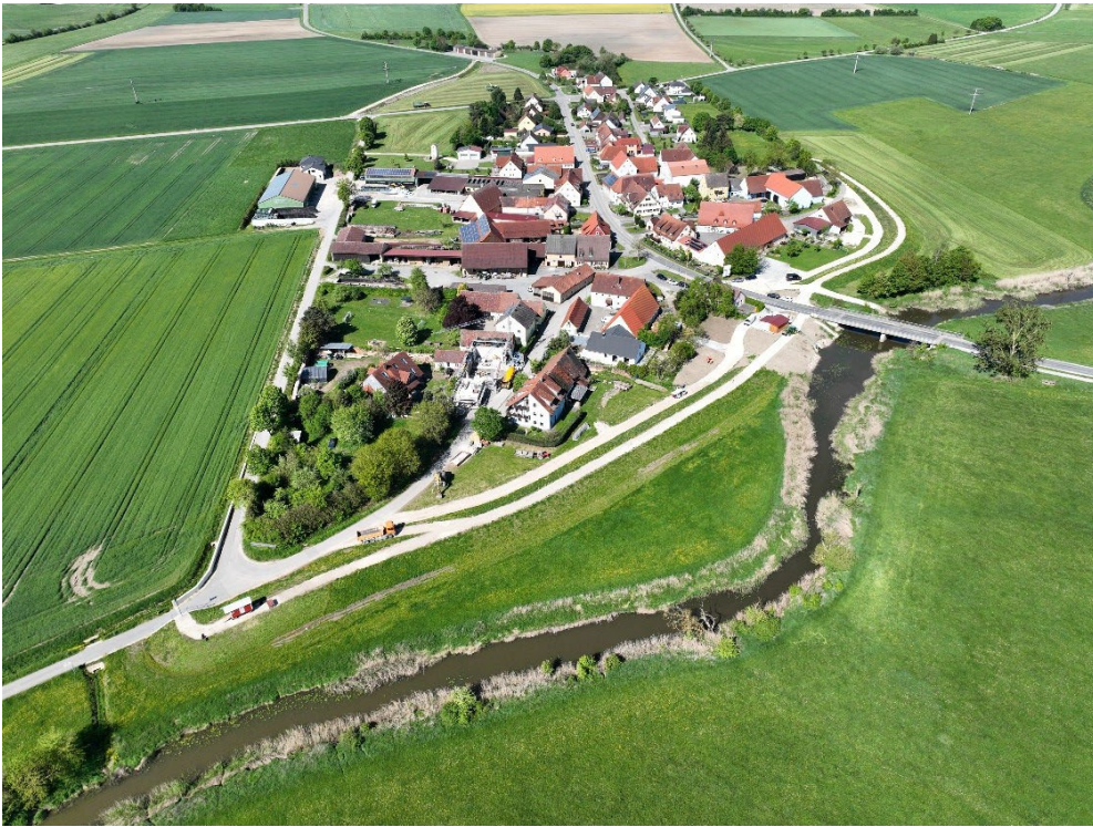
Abbildung 1: Drohnenaufnahme Hochwasserschutzdeich (Quelle: WWA Ansbach)
