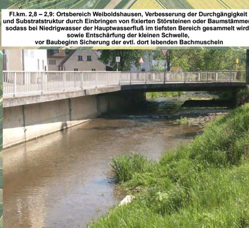
Fl.km. 2,8 – 2,9: Ortsbereich Weiboldshausen, Verbesserung der Durchgängigkeit und Substratstruktur durch Einbringen von fixierten Störsteinen oder Baumstämmen, sodass bei Niedrigwasser der Hauptwasserfluß im tiefsten Bereich gesammelt wird, sowie Entschärfung der kleinen Schwelle, vor Baubeginn Sicherung der evtl. dort lebenden Bachmuscheln
