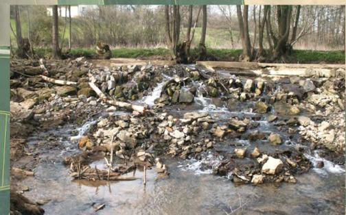
Fl.km. 3,8: Teilungswehr der Gollischmühle, Wiederherstellung der biologischen Durchgängigkeit durch ein Umgehungsgerinne oder eine massive Entschärfung des Gefälles; die Alternative der Wiederherstellung der Durchgängigkeit des Entlastungswehrs ist zu überprüfen, vor Baubeginn Sicherung der dort lebenden Bachmuscheln
