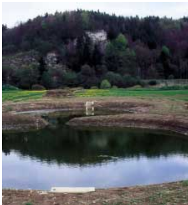
◀ Baustelle der Kläranlage Esslingen
