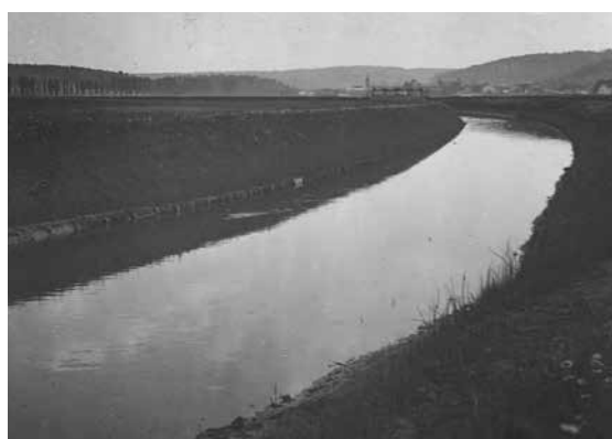
Fertiggestellte Korrektionsstrecke oberhalb von Treuchtlingen mit Uferschutzbauten; Juni 1913
