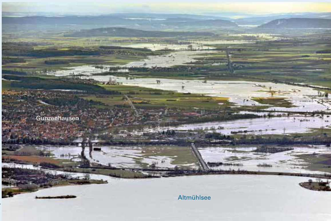
Seit der Inbetriebnahme des Überleitungssystems können kleinere Hochwasserereignisse verhindert und größere Hochwasserereignisse gemindert werden.
