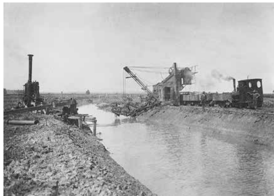
Zwischen 1910 und 1920 wurde die Mittlere Altmühl mit schwerem Gerät zu einem gleichförmigen Kanal ausgebaut.
