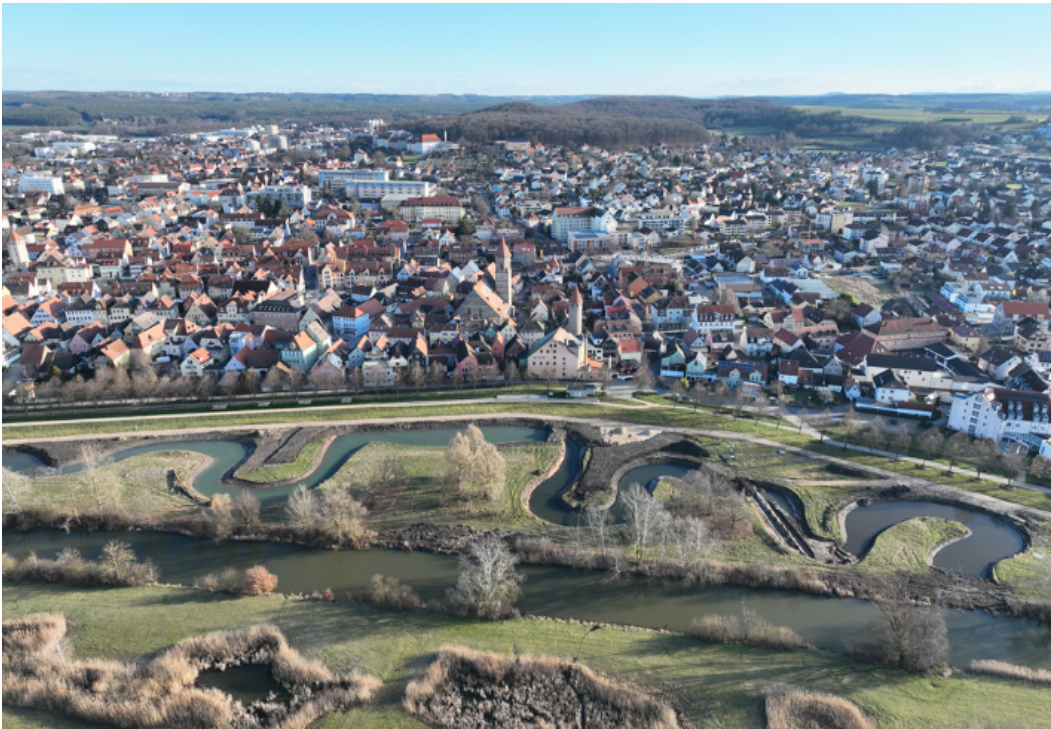
neuer Gewässerlauf (Drohnenaufnahme vom 17.01.2023, Quelle: WWA Ansbach)
