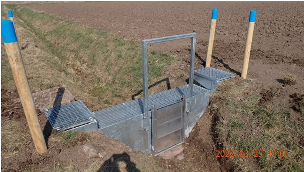
Foto: Eingebautes Absperrbauwerk (Quelle: WWA Ansbach)
