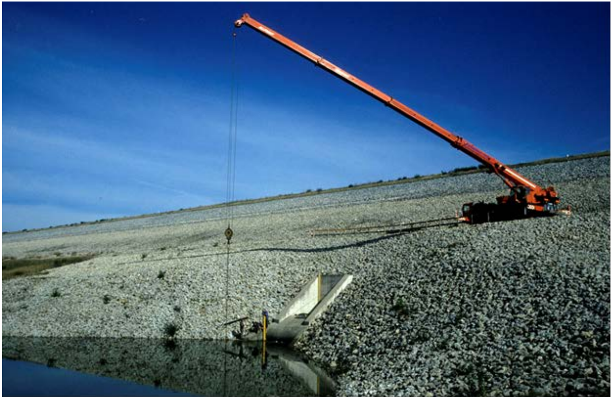
Abbildung 1: Großer Brombachsee 1993 bei 6 m Einstau, Blickrichtung auf Hauptdamm mit Sicht auf den Grundablass
