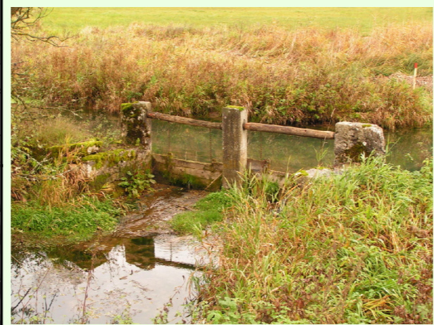
Durchgängigkeit am Wehr der Flemmühle durch Anlegen einer Rampe herstellen
