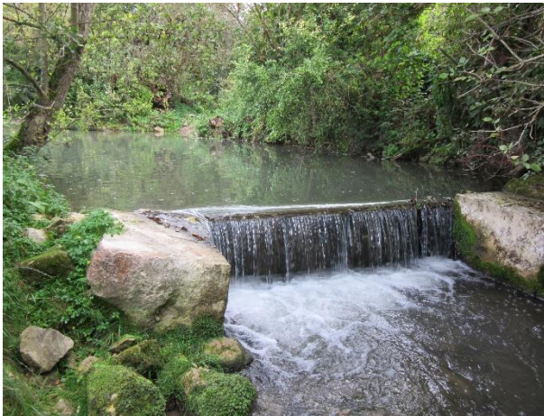
Abbildung 1: Ist-Situation 2020 im Ortsbereich von Schambach: Absturz verhindert die Durchgängigkeit für zahlreiche Fischarten (Foto: WWA Ansbach)
