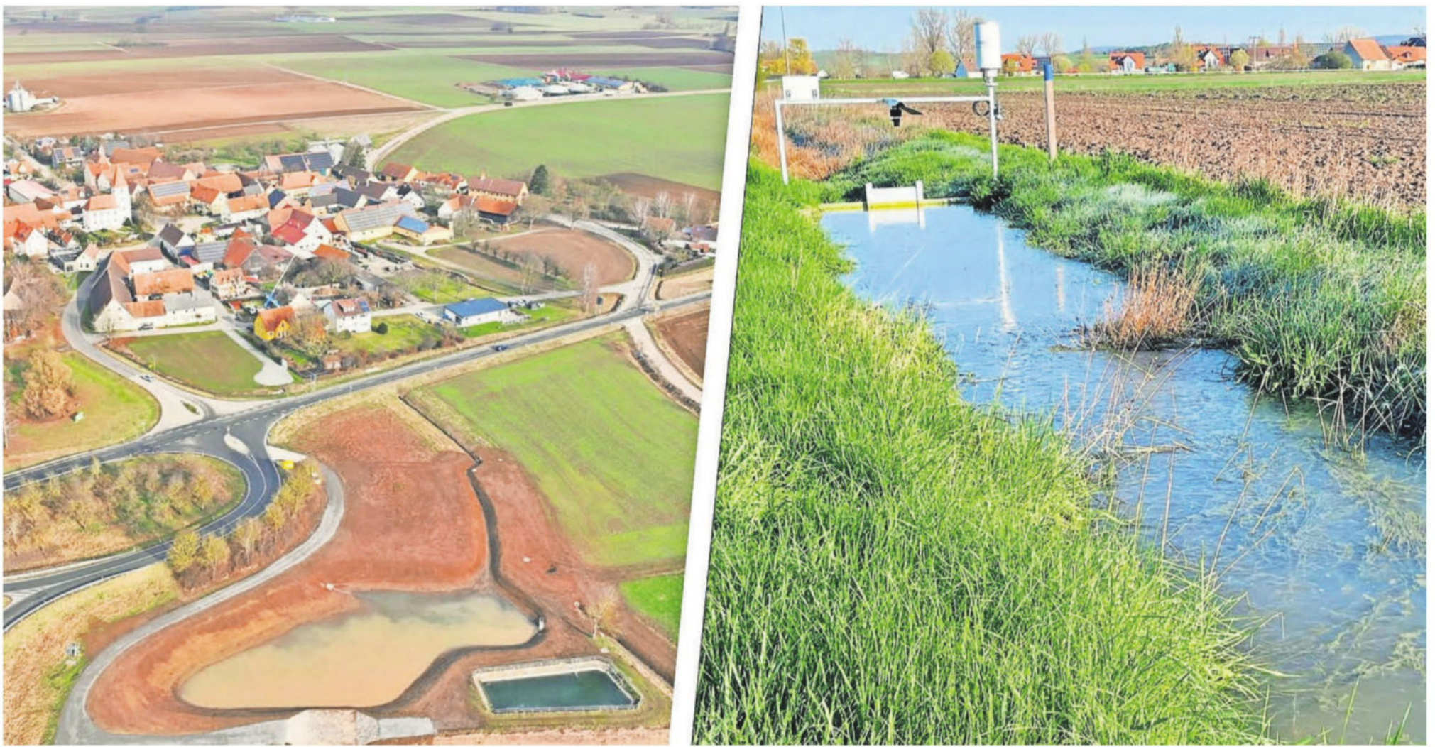
Kampf gegen die Trockenheit: Umfunktionierte Teichkläranlagen (linkes Bild bei Neuherberg) und Entwässerungsgräben an Äckern (bei Oberndorf) als Wasserspeicher - so könnte die Zukunft aussehen. Foto: Stefan Blank/Sandra Frosch/Wasserwirtschaftsamt
