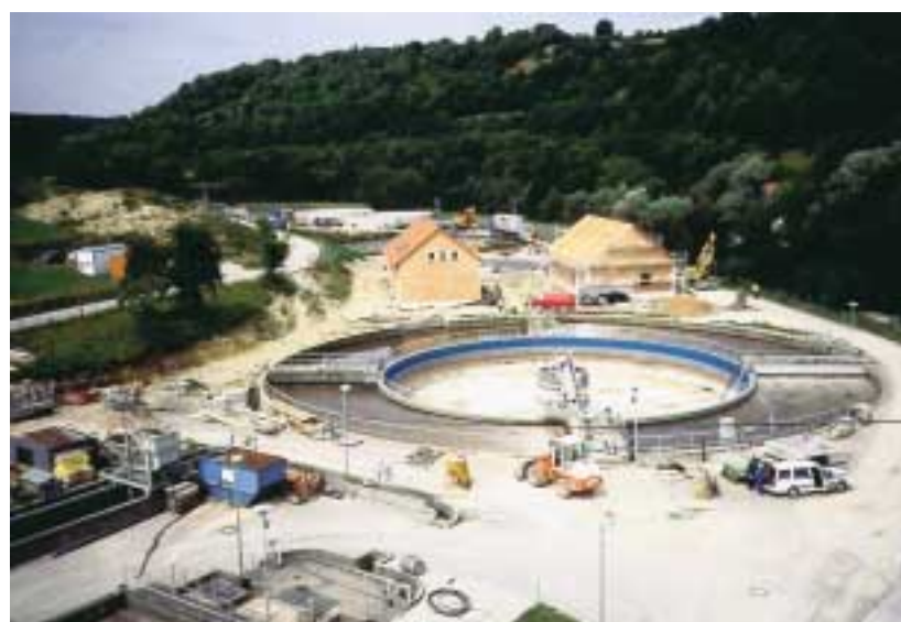
▲ Umbau der Kläranlage Rothenburg ob der Tauber
