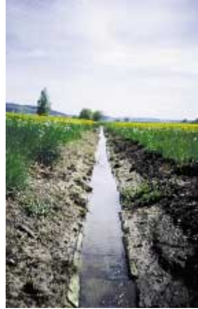
▲ Der Ausbau mit Sohlschalen verhindert die Eigendynamik des Gewässers
