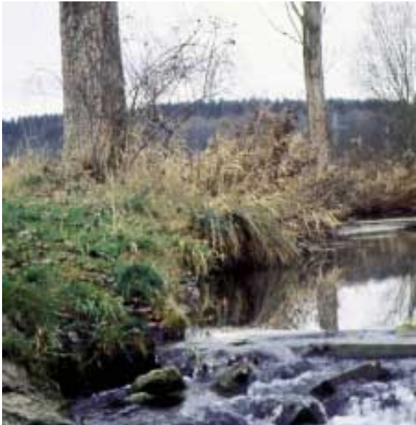
◀ Rampe am Schambach
