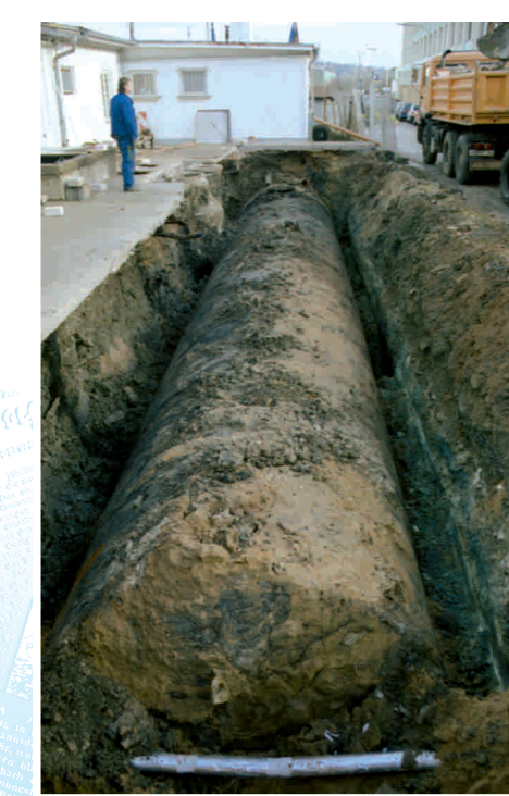
Der Tank einer ausgedienten Tankstelle wird ausgebaut
